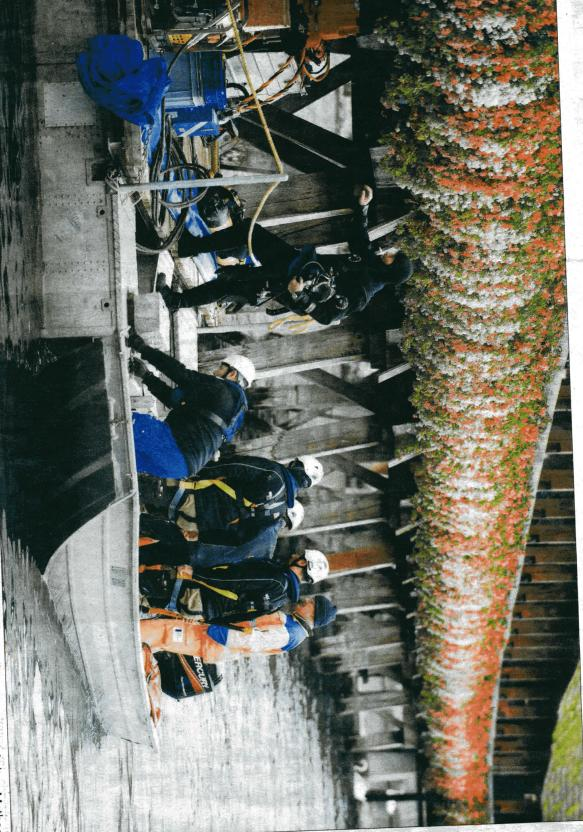
Zuletzt wurden 2012 zwei Pfähle der Kapellbrücke mit der von Hans Banholzer entwickelten Method ersetzt. Zwei Taucher entfernten dafür unter Wasser die morschen Teile und setzten neue ei
